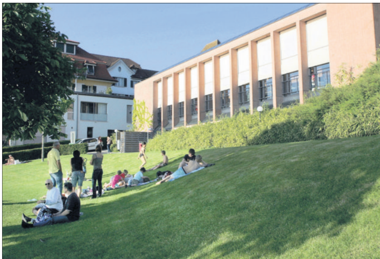
Die Balkone seien ein zu grosser Eingriff in die Fassade, findet ein Experte. Archivbild Werner Schelbert
